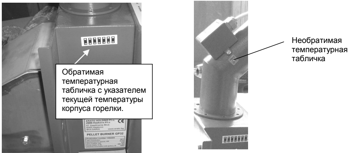
Рис. № 7 Размещение температурных табличек на горелке
