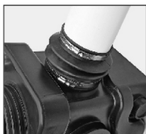
Рис. 9 Монтаж вентиляционного трубопровода
