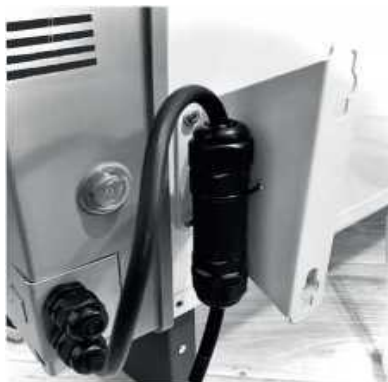
Рисунок 4 - Крепление кабеля на кронштейн конвектора
