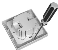
Рис. 7. Демонтаж лицевой панели
