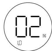
Рис. 15. Настройка отопительной кривой.
