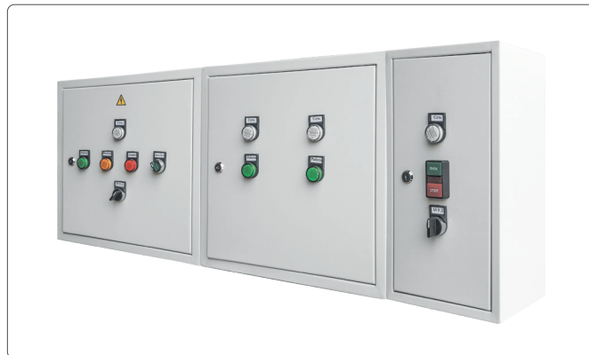
Рис. 3. Приточная установка с электрическим нагревом (2 ступени), двигатель без частотного преобразователя
