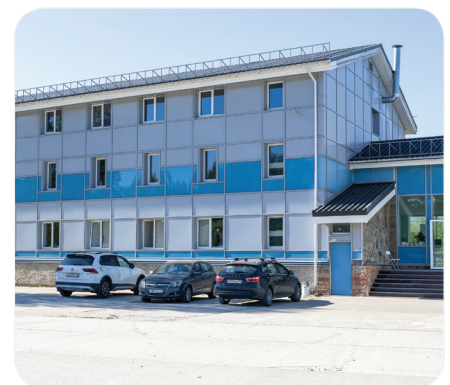
Производственное предприятие. Л.О. Новое Девяткино, 1-ый проезд, д. 16 Администрация, офис ИТР, производственный комплекс.
