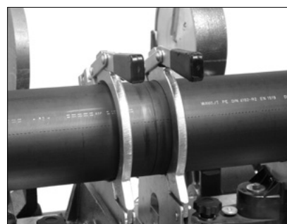
Трубы, правильно подготовленные к сварке
