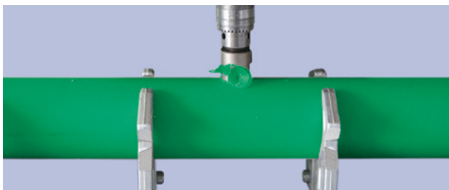
① С помощью специального сверла (столлик слева) просверлите отверстие для трубы.
