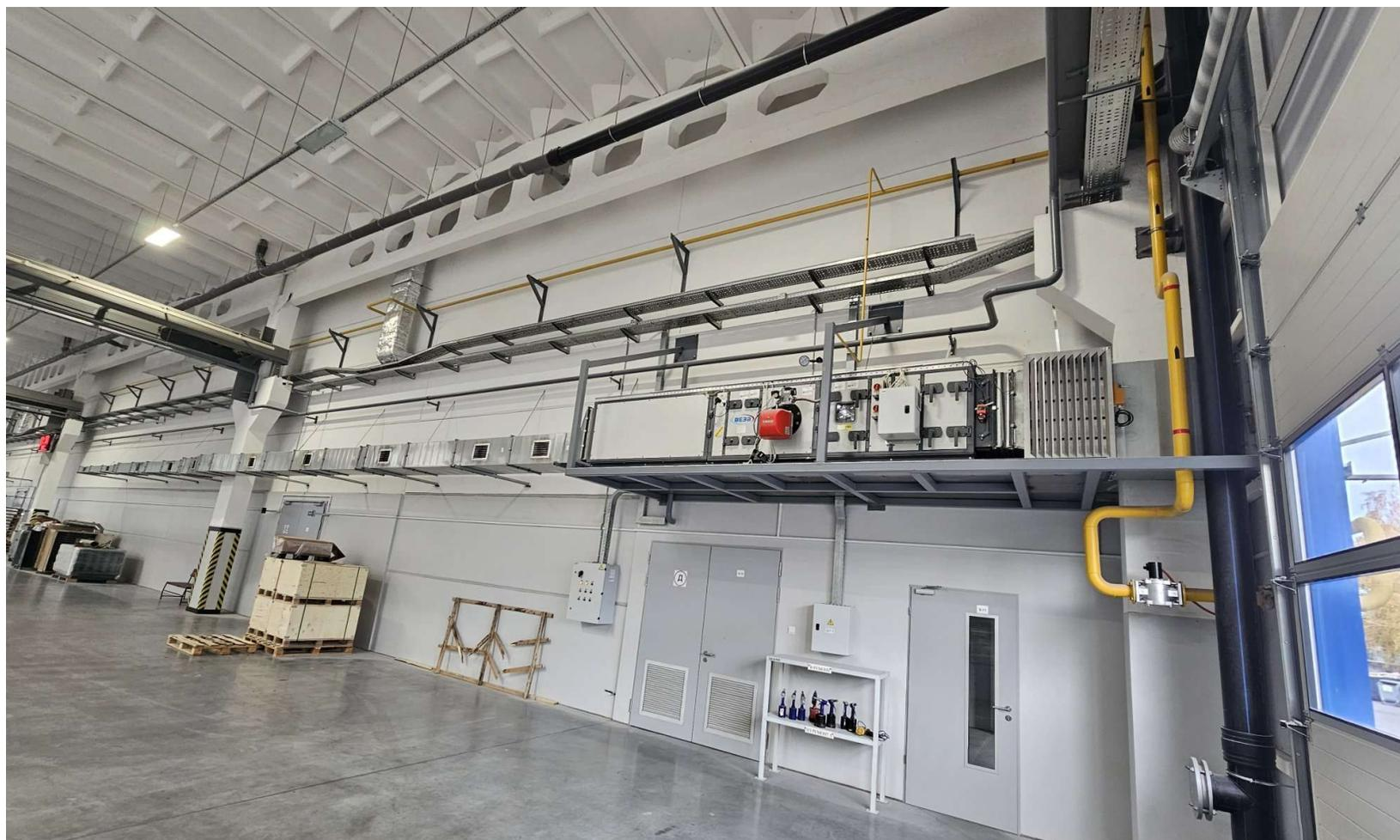
**Основной принцип применения стандартных воздушонагревателей – проектирование с запасом по тепловой мощности к расчетным данным на систему отопления и вентиляции.**
