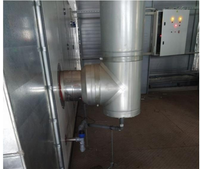
Патрубок для дымовой трубы и вывод слива конденсата продуктов сгорания из секции нагрева по умолчанию выполняются на стороне, противоположной сервисной.
