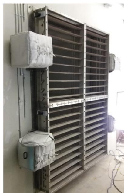
*Условия окружающей среды внутри некоторых туннелей могут быть высококоррозионными, поэтому материал, используемый для изготовления этих вентиляторов, должен быть соответствующим и иметь антикоррозионное покрытие для увеличения их срока эксплуатации.*
