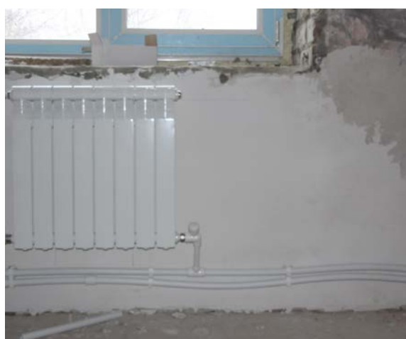
Рис. 16. Пример некомпенсированного трубопровода.
