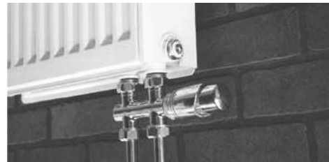
Непосредственное подключение трубы к радиатору с помощью H-образной гарнитуры и медных L- и T-образных трубок
