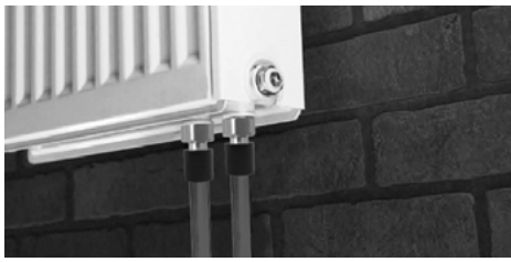
Непосредственное подключение трубы к радиатору с помощью медных L- и T-образных трубок
