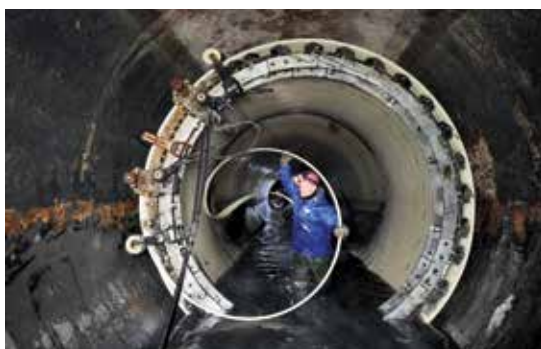
Санация канализационного коллектора профилем СПИРАТЕХ, г. Иваново
