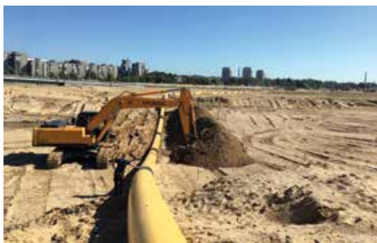
Строительство инфраструктуры для чемпионата мира по футболу 2018 г., г. Калининград
