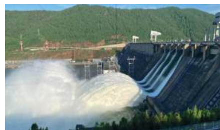
Саяно-Шушенская ГЭС им. П.С. Непорожного
