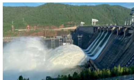
Саяно-Шушенская ГЭС им. П.С. Непорожного
