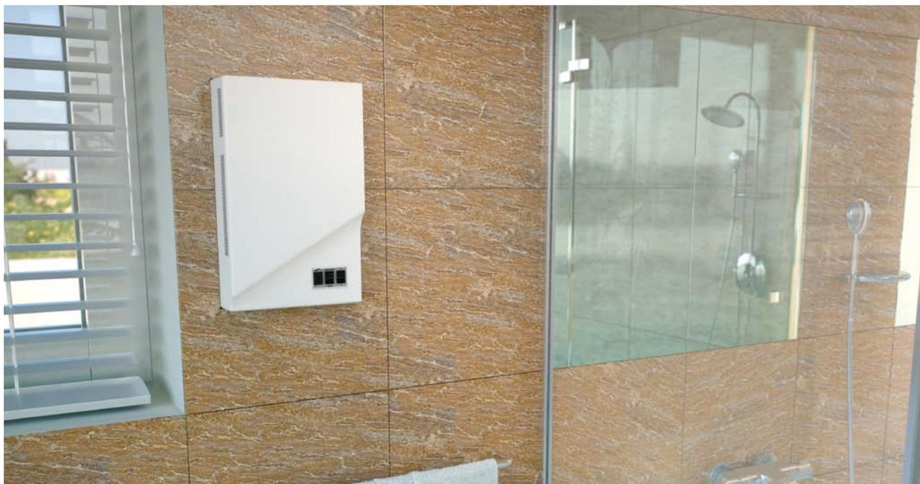
Локальная вентиляционная установка с рекуперацией тепла, автоматическим устранением влажности и электронным управлением заслонкой.
