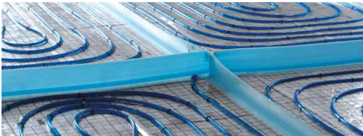
Рис. 14. Деление греющей поверхности разделительными швами.
