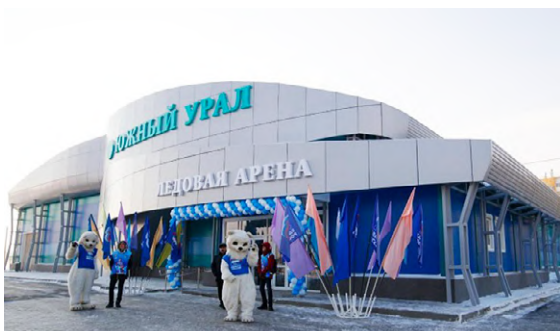
::::: ФОК Южноуральск ::::: г. Южноуральск
