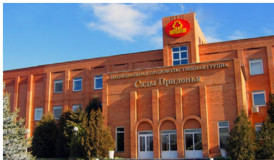
Цех Сады Придонья г. Волгоград
