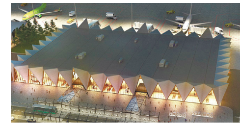
Реконструкция аэродрома аэропорта Ямало-Ненецкий АО, Новый Уренгой 2022
