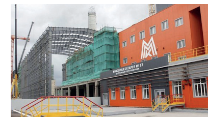
Реконструкция КХП ПАО «ММК» Магнитогорск 2023
