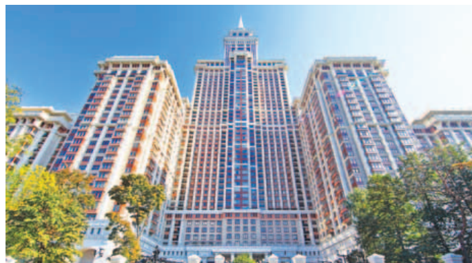
Объект компании: Жилой комплекс «Триумф-Палас» (57 этажей).
