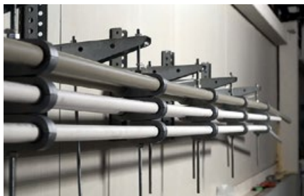
:: Фото 7. Пластиковые хомуты для многоуровневых трубопроводных трасс
