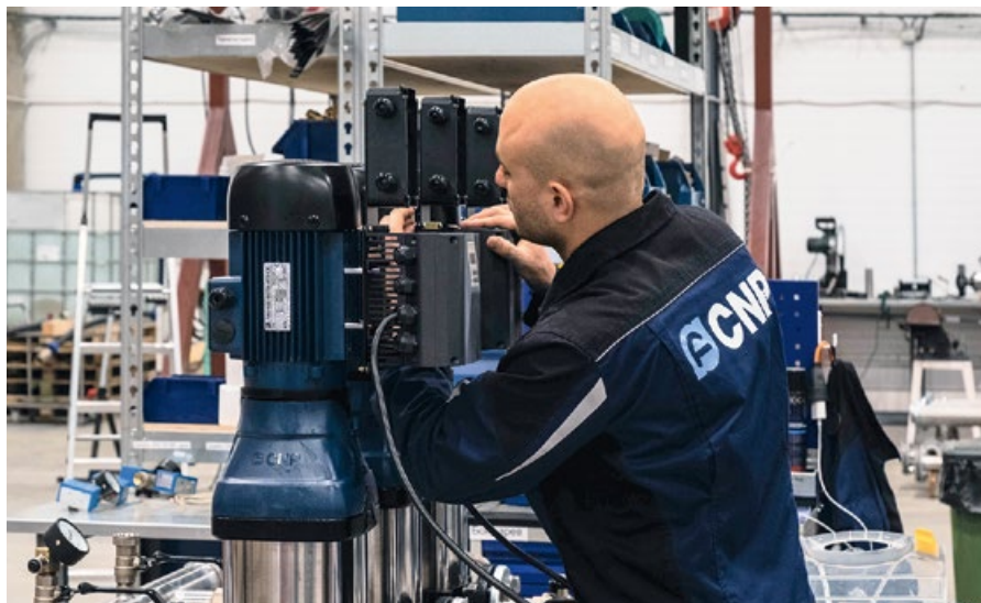
❖ Процесс сборки установки повышения давления на производстве в Есипово
