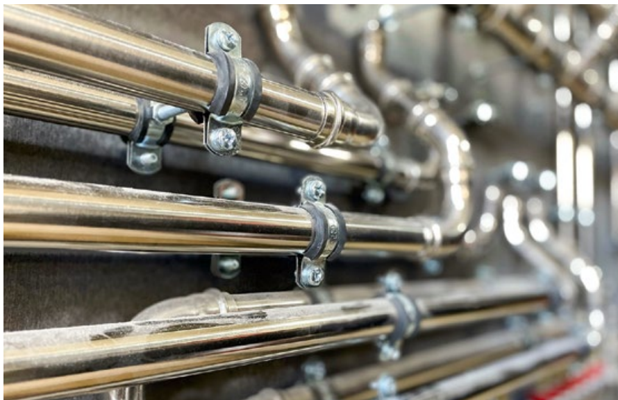
:: Фото 2. Хомуты быстрого монтажа Formfix
