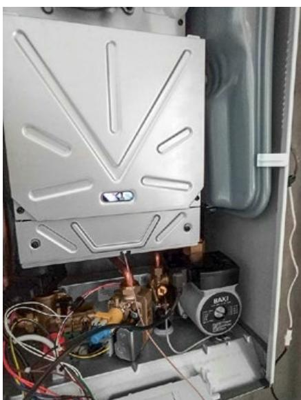
Котлы ECO Star оснащаются всем необходимым для работы системы отопления и имеют закрытую камеру сгорания. Котёл ECO Star — двухконтурный, то есть гарантирует возможность производства горячей воды для хозяйственно-бытовых нужд. Котлы адаптированы к российским условиям и устойчиво работают при понижении входного давления природного газа до 5 мбар в диапазоне питающего напряжения 170–270 В, обеспечивая не менее 50% мощности.
